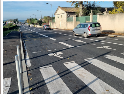
la 2ème tranche des travaux de la D40 en cours de finition (Nîmes Métropole et Commune de Caveirac).
