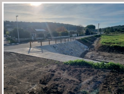
voie partagée et sécurisation hydraulique du chemin de Bernis.
